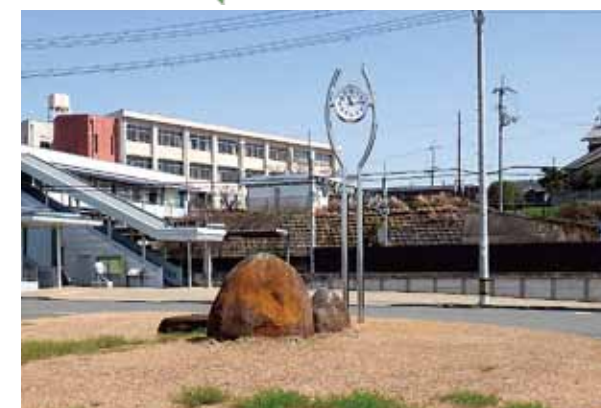
多賀駅前 屋外時計設置工事
