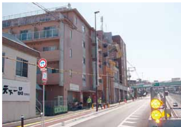
国道9号京都西立体千代原口 電線共同溝照明設備設置工事
