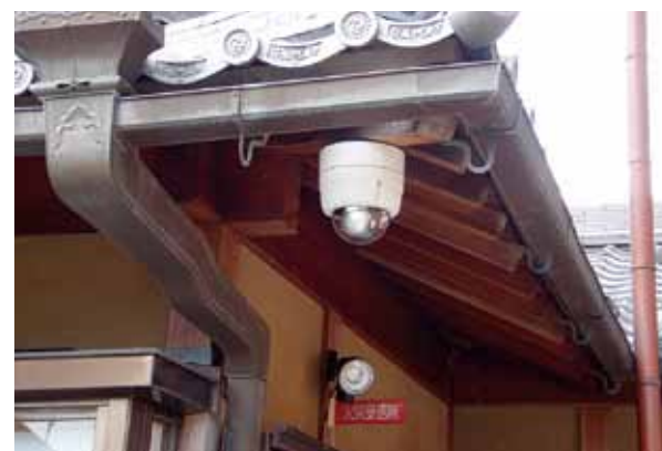
K寺様 防犯カメラ設置工事
