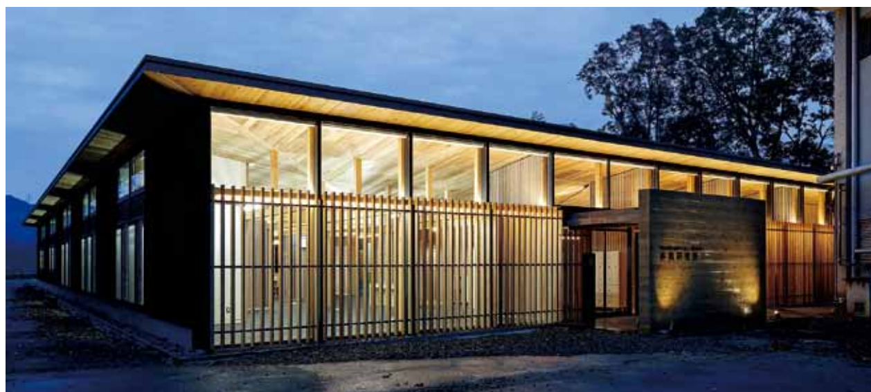
京都府茶業研究所本館 新築工事（電気設備工事）
