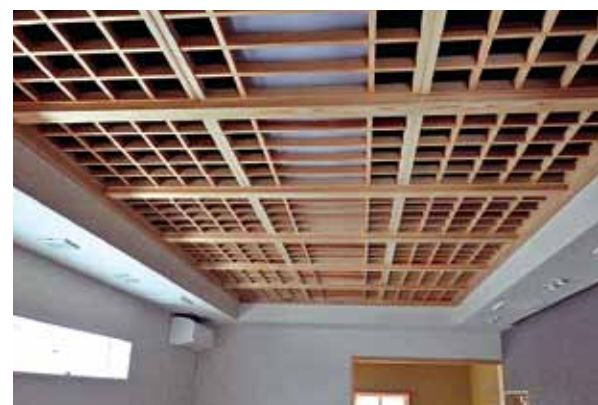
U様 店舗改装工事（空調・換気設備工事）
